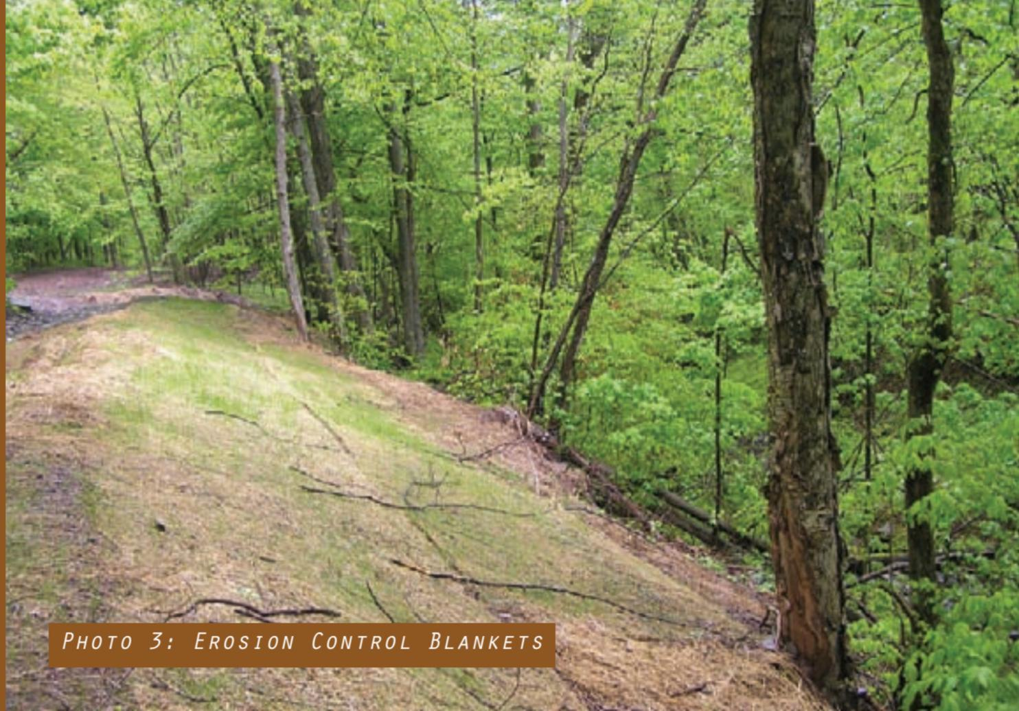
*PHOTO 3: EROSION CONTROL BLANKETS*
